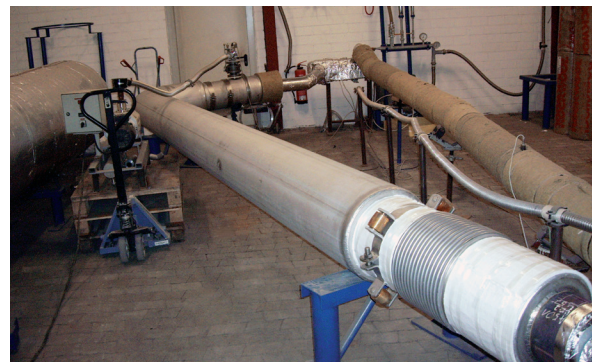
Bild 3: FW-Kammer-Rohr während Montage
