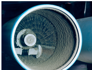
Auskleidung durch das Anspritzverfahren
