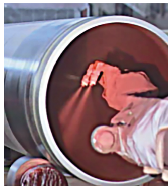
Auftragen der Flow Coat-Beschichtung
